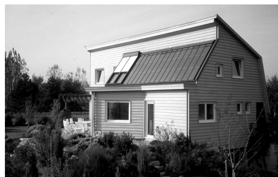
Fig. 1. – Vue de l'habitation bioclimatique à PSD mixte près de Mulhouse (France)
