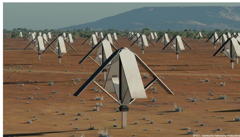
Рис. 1.10. Апертурная решетка из дуополяризованных дипольных антенн, используемых на нижних частотах рабочего диапазона
