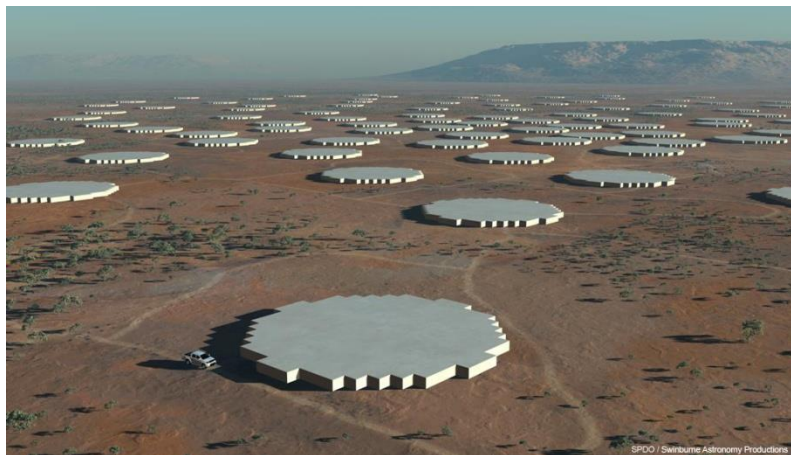
Рис. 1.11. Панели из апертурных решеток, используемых на средних частотах
