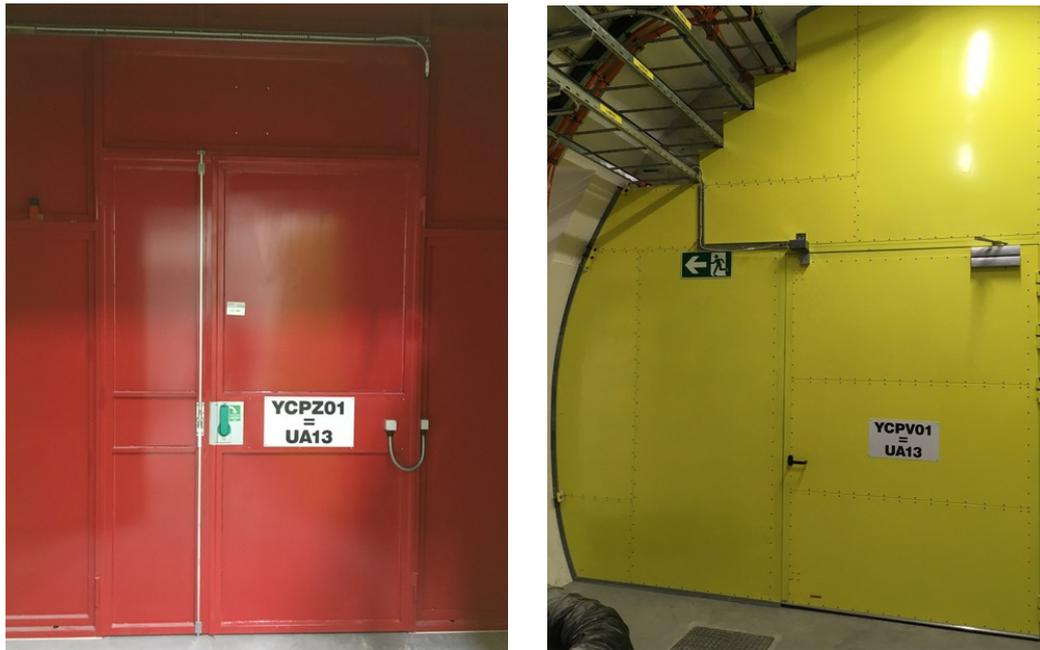
Figure 34: LASS end-of-zone door (*left*), ventilation door (*right*).
